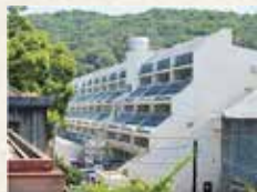
階段校舎（平成18年）
