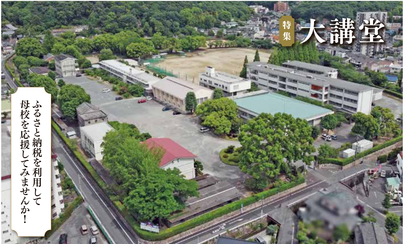
現在の校地を北西より望む（ドローン空撮高度40m、2021年6月撮影）
