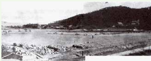
造成中の六高用地
