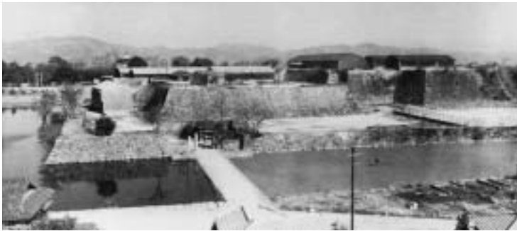
廃屋となった内山下校舎
