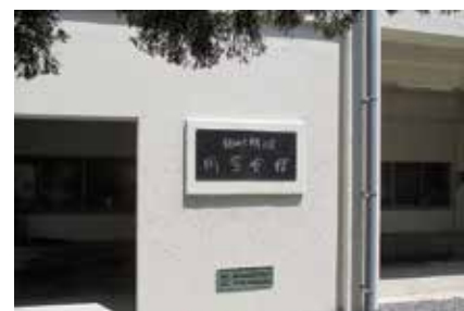
西前面にできた耐震壁に移された「同窓会館」銘板
