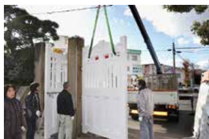
門扉取付け風景
