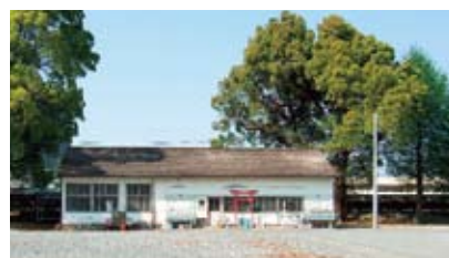
解体後の風景 (平成 26 年 4 月)
